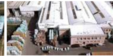
Cotto Petrus Uffici, Stabilimento Produttivo, Atomizzatore e Magazzino (Offices, Production Plant, Atomizer and Warehouse)
